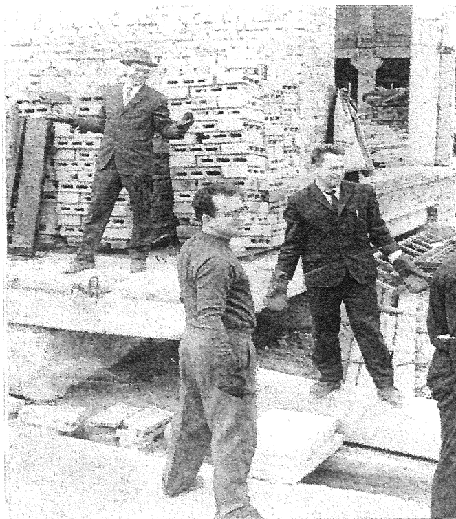
Глушков В.М. и Сергиенко И.В. на субботнике (строительство нового корпуса Института кибернетики)
